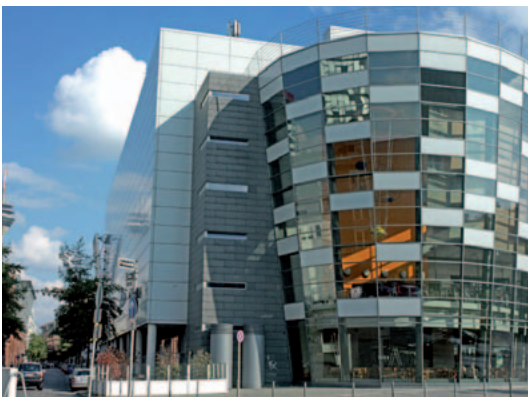
UCI Kinowelt in Düsseldorf: Die ARWOBAU ist bundesweit als Immobiliendienstleister tätig – die Geschäftsanwendungen werden komplett von Berlin aus bereitgestellt.
